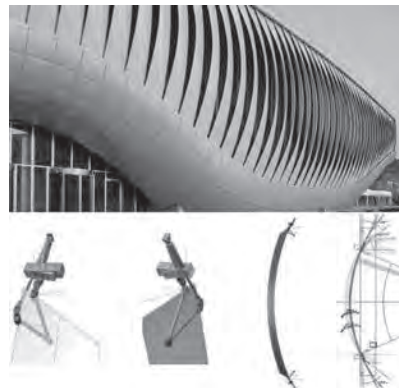
图15: 韩国丽水世博会主题馆建筑表皮及驱动结构
